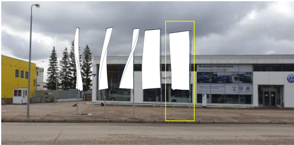
№ Ф – 26, г. Sterлитамак, около нежилого здания по ул. Профсоюзная, 1 (литер № 5)
