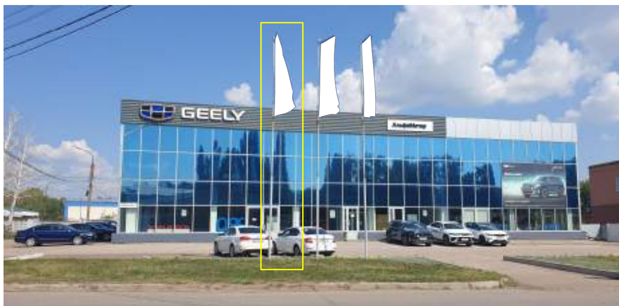
№ Ф – 50, г. Sterlitamak, около нежилого здания по ул. Шаймуратова, 2А (литер № 1)
